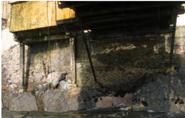
Arriostres ubicados en la base del puente son de dimensiones menores al soporte de carga por lo que se debe reforzar dichos perfiles, para evitar el colapso del puente.
