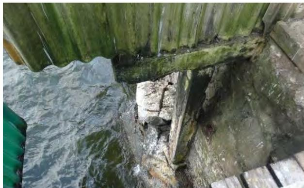
Pilotes de madera sostenedoras de la carga del muelle se encuentran con rajaduras y presencia de material orgánico.
