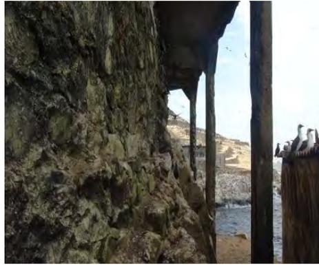
Las columnas de soporte del Depósito Principal se encuentran en mal estado y con alto riesgo.
