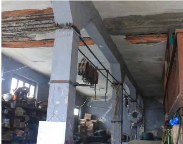
Se aprecia que en las columnas se han colocado abrazaderas para amortiguar el derrumbamiento de las columnas resquebrajadas.
