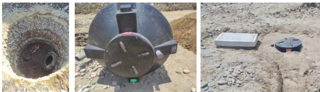
Gráfico 16. Registro fotográfico de la instalación del biodigestor
