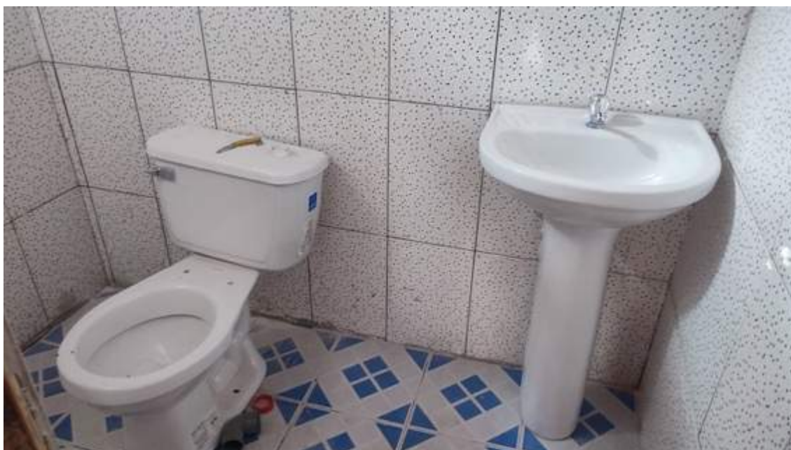
Gráfico 12. Baños remodelados caleta el Ñuro
