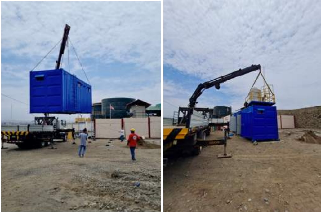
Gráfico 14. Colocación e instalación del módulo de baños
