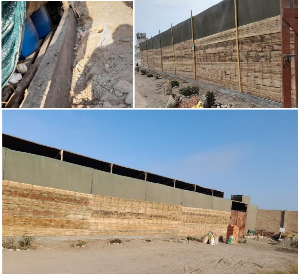
Figura 1. Cerco perimétrico de la planta a base de caña Guayaquil 86 m 2 (43 x 2 m) y Construcción de la base de concreto 46 m de largo x 60 cm altura x 20 cm de ancho sobre perímetro de la planta.
