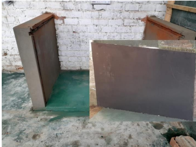
Figura 3. Armario de ladrillo tarrajado para la congeladora de 1m x 1m x 60 cm y puerta corrediza con plancha trip fenol.
