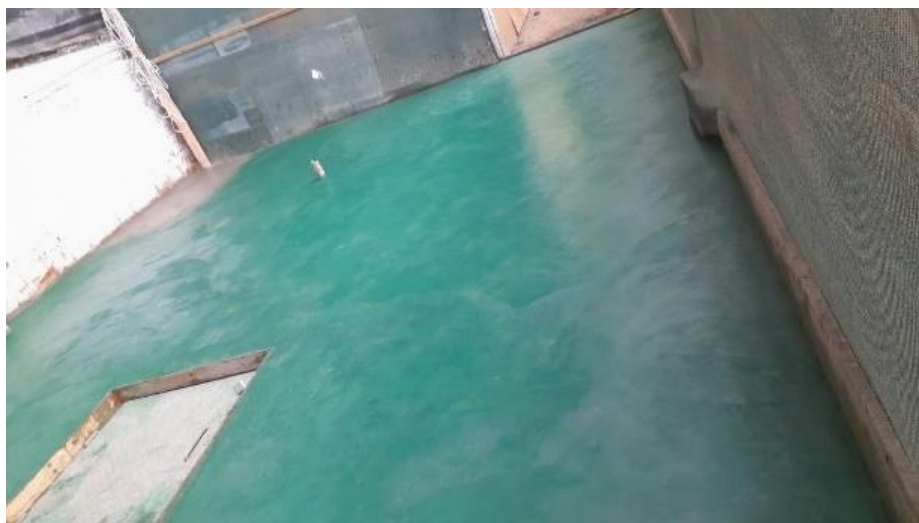
Figura 2. Loza de concreto Construcción de 25 m 2 de loza pulida de concreto sobre el almacén sótano
