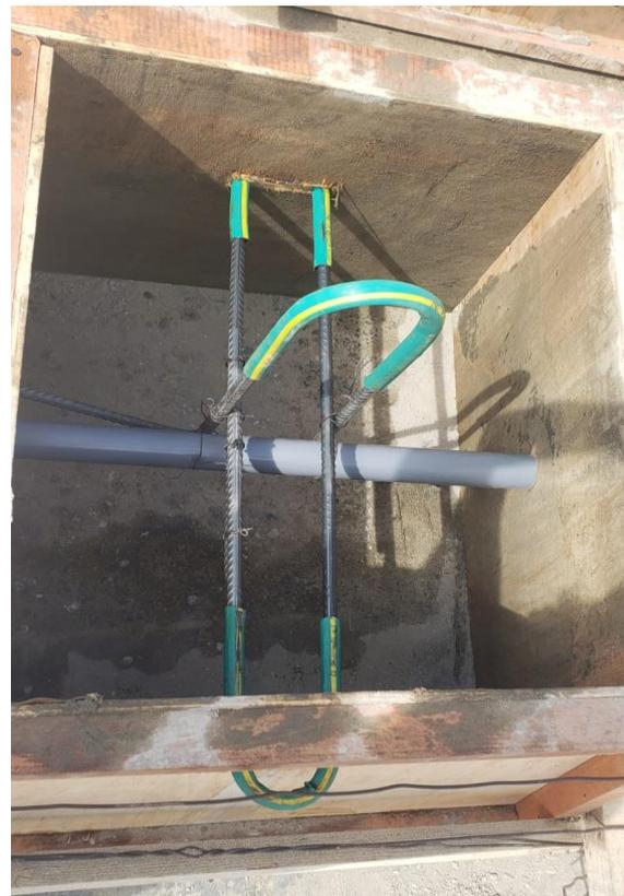
Figura 4- Disposición de listones de madera y triplay para la confección de Anclajes. Se observa la disposición de las varillas de metal que dan firmeza al anclaje y a su vez sirven para colocar los agarres con los cuales se puede maniobrar y amarrar la Long-Line.
