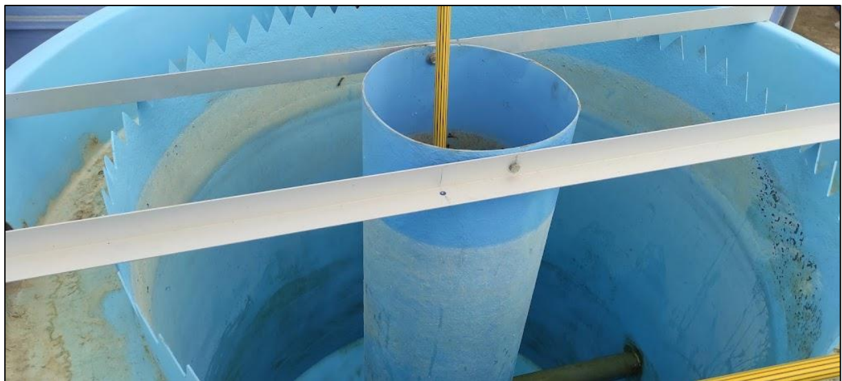
Figura 5. Filtro mecánico-Sistema radial Fuente: Estación IMARPE-área Acuapónico 1era Sección
