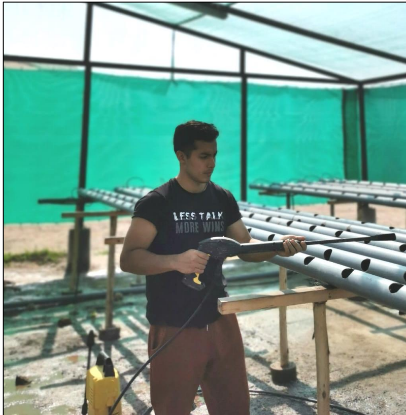
Figura 43. Agua a presión con la parte interna del tubo de cultivo con hidrojet Fuente: Estaciónn IMARPE-área Acuapónico 2da Sección
