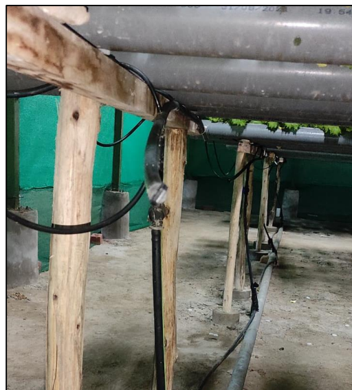
Figura 33. Imagen real del mecanismo de conducción de ingreso de agua madura a los tubos de cultivo.
