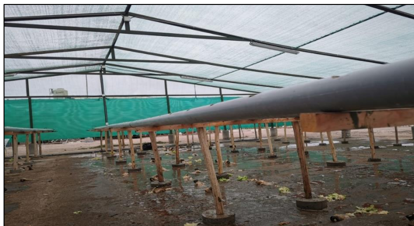
Figura 40. Imagen real de una serie de soportes para tubos de cultivo de 12 metros de longitud.
