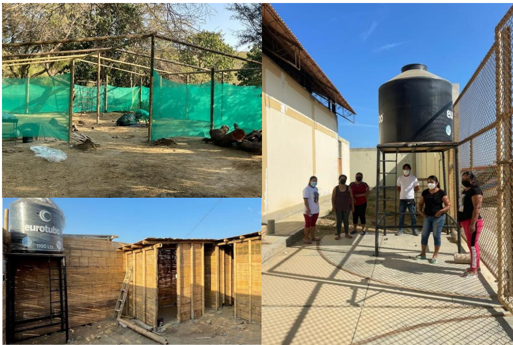
Construcción en área piloto Máncora
